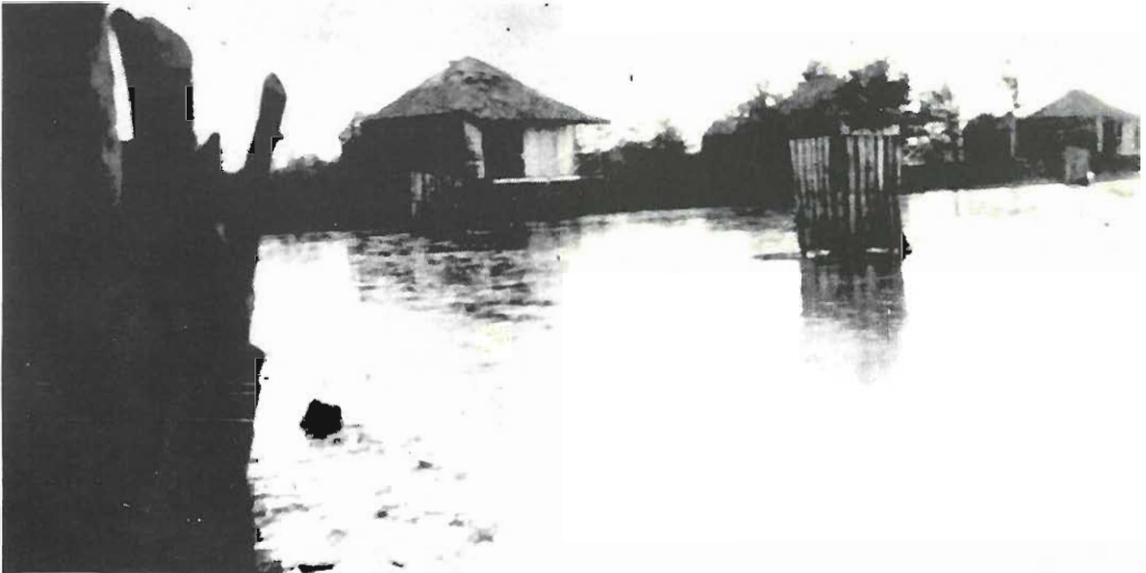
Sateiden ja tulvan aikaan muutoin peräti kuiva suomalaissiirtokunta saattoi näyttää tällaiselta. Juuri tulvia ajatellen valtion rakennuttamat palmukattoiset asunnot oli rakennettu korkeahkojen puupilarien varaan.
