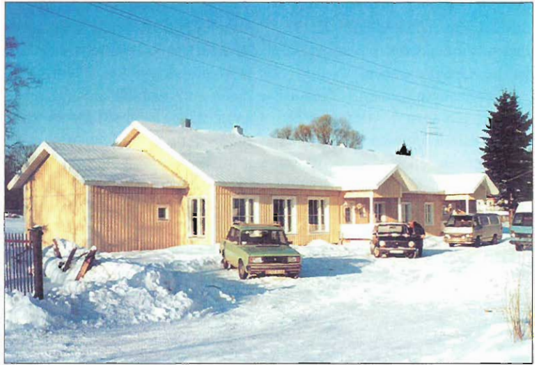
Hatsina, Taaitan vanhusten palvelutalo, joka on peruskorjattu Suomen lähialuemäärärahoihin.
