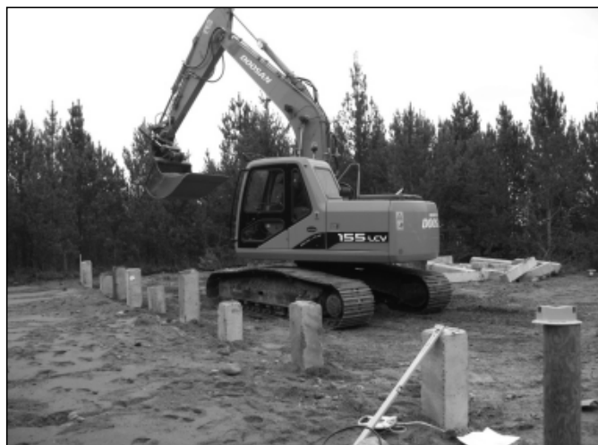
Australian parakin rakennustyömaa on aloitettu Kalajärven Maaailman Raitilla.
