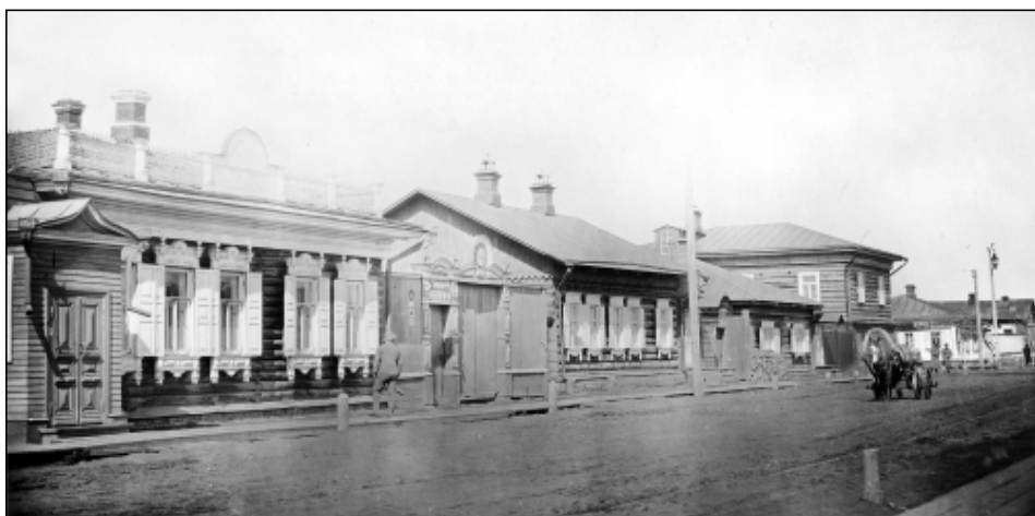
Kuva 1. Varlamovskaja-katua Omskissa 1910-luvulla. Vasemmalla suomalaisena pappilana 1902–18 toiminut talo, jonka Johannes Granö omisti 1902–13; sen jälkeen hänen poikansa Paavo Granö vuoteen 1919, jolloin talo siirrettiin bolševikeille, ensimmäisenä asukkaana Suomesta paennut punakaartilaispäällikkö Heikki Kaljunen. Pappilasta oikealle on virolaissyntyisen kiinteistöurakoitsija Valsin kolme taloa, joista keskimmäinen on myöhemmin purettu. Valokuvannut J.G.Granö 1915. Suomalaisen Kirjallisuuden Seura, J.G.Granön kokoelma.
