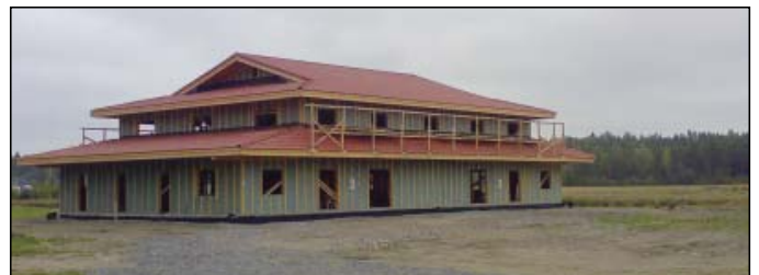
Turkuun rakenteilla oleva buddhalais-temppele. Kuva: Ismo Söderling.
